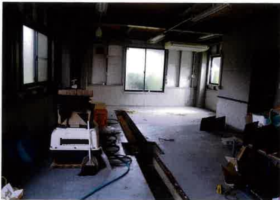
②屋内の状況 車庫
