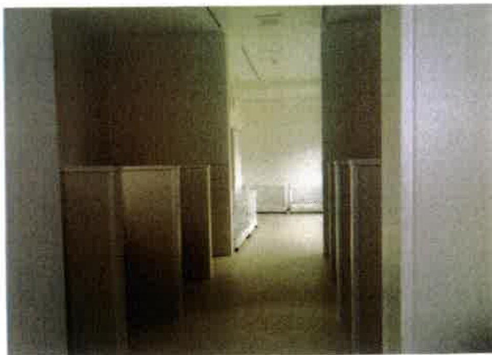
屋内の状況（2階 ペットホテル2からペットホテル1方向撮影）
