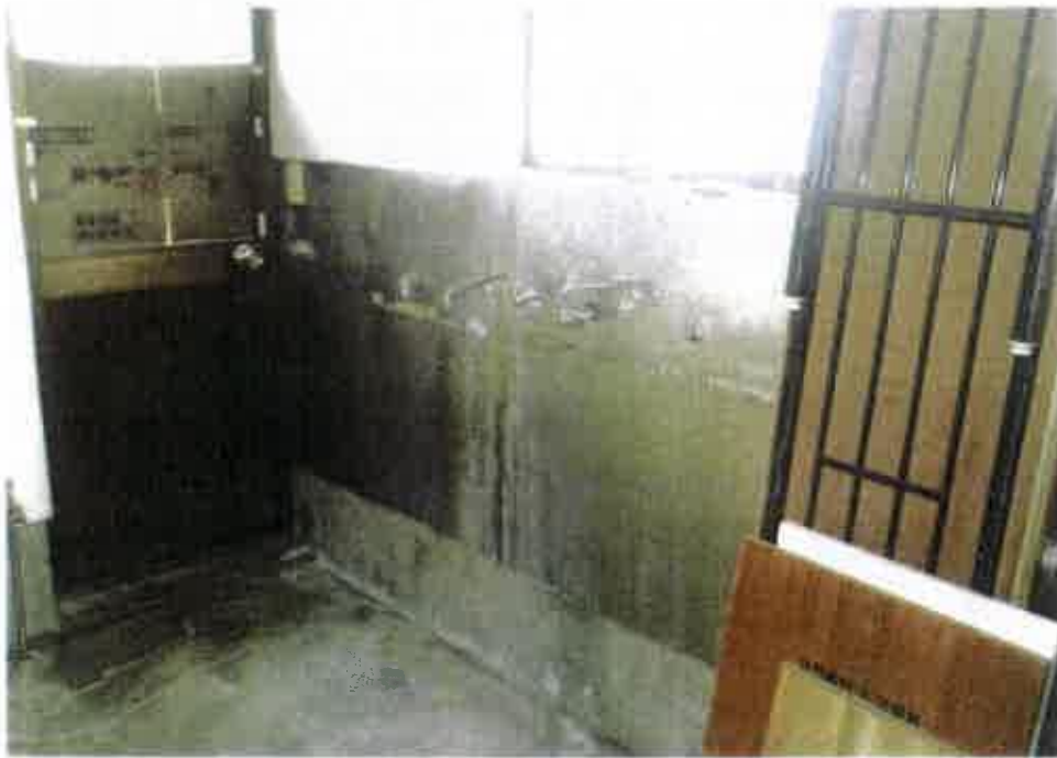
屋内の状況（1階 厨房（洗い場））
