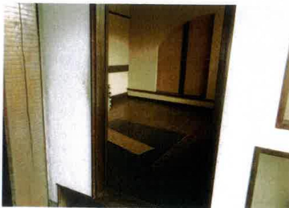
屋内の状況（1階 店舗 個室6）
