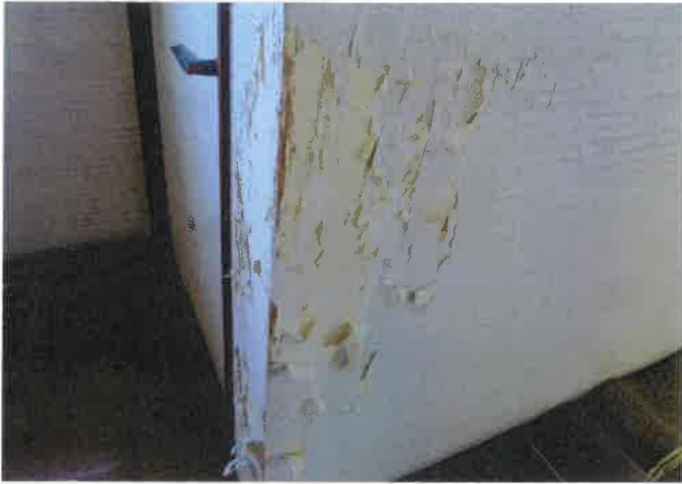
⑤ 屋内の状況 2階廊下の 壁の状況
