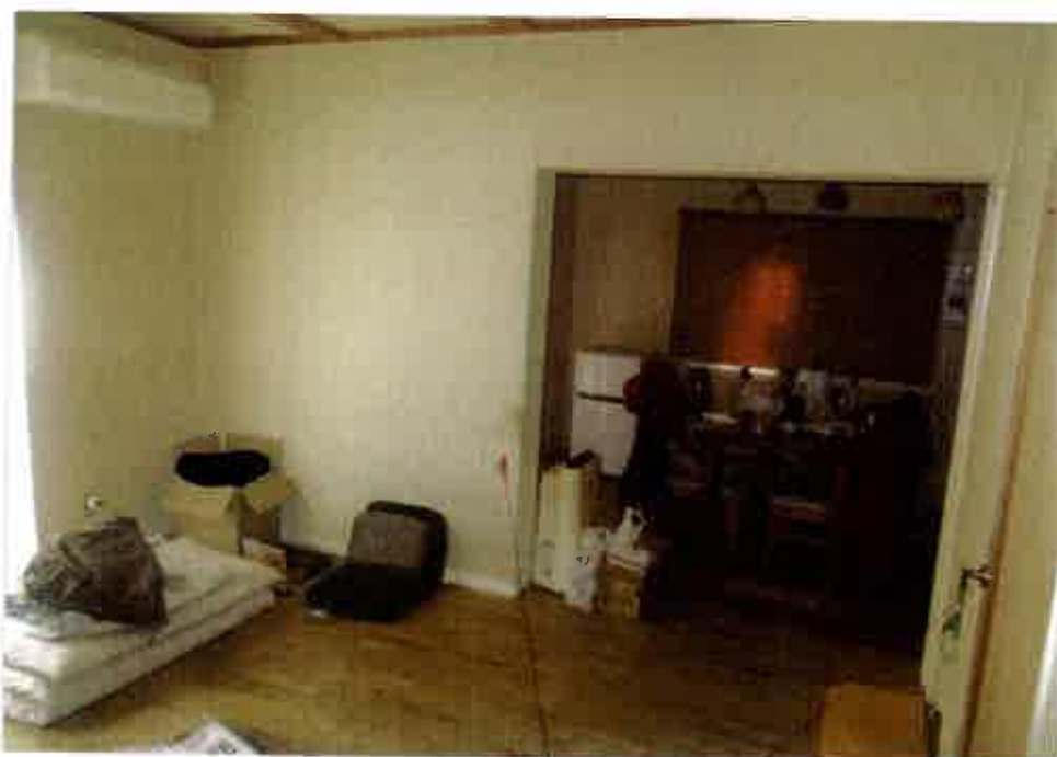
壁面の損傷の状況
