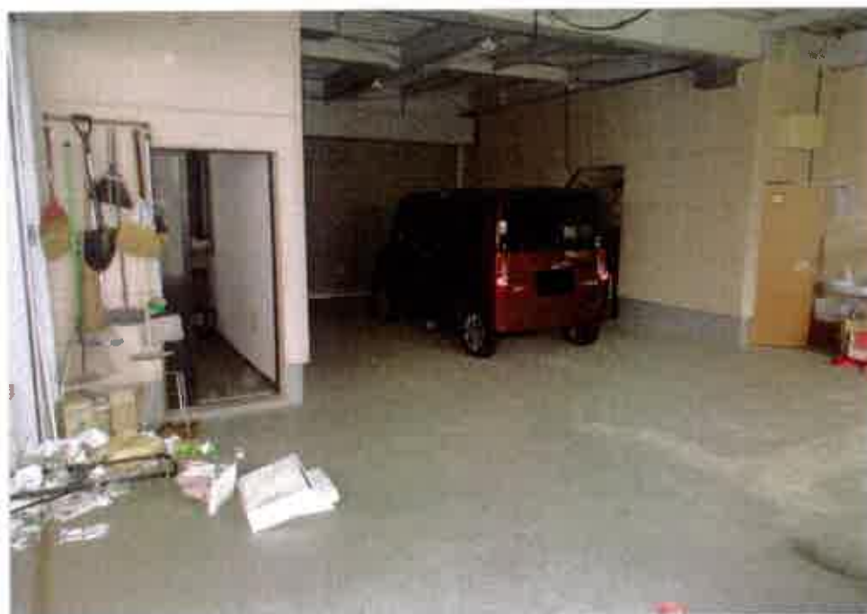
屋内の状況（1階 倉庫）
