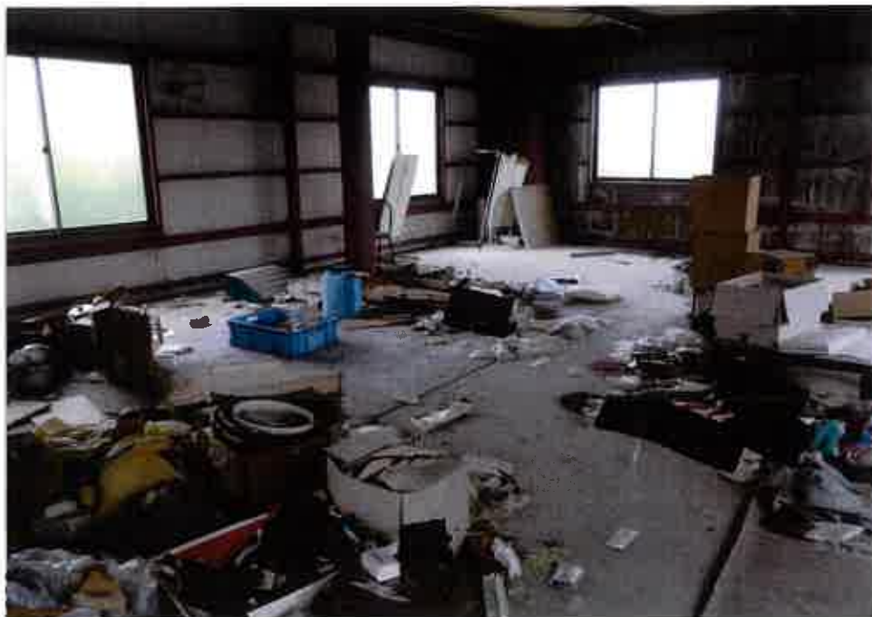
⑧屋内の状況 倉庫 3 (物件 5)
