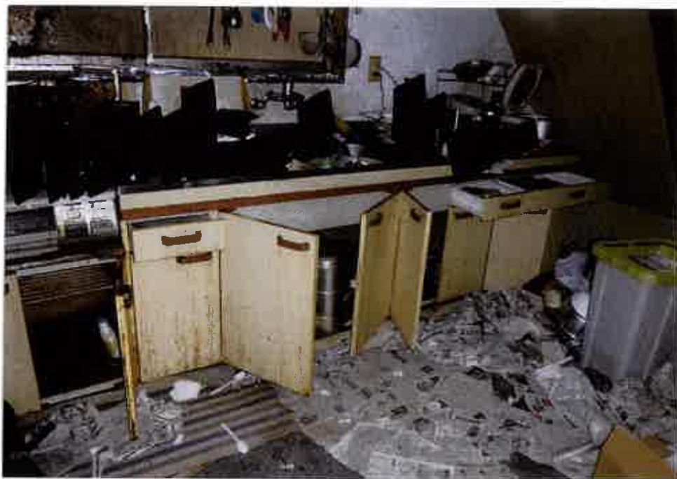
③屋内の状況 台所・食堂 (物件2)
