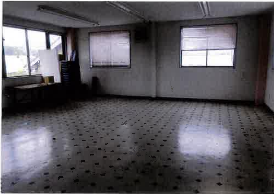
⑦屋内の状況 事務所 1 (物件 5)
