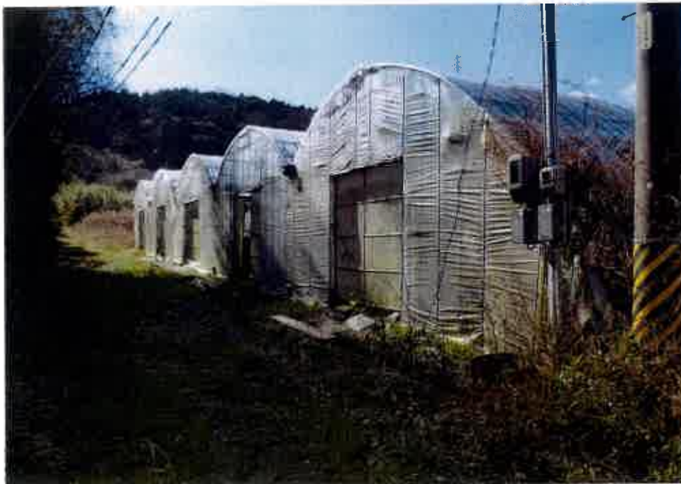
④ビニール ハウスの状況
