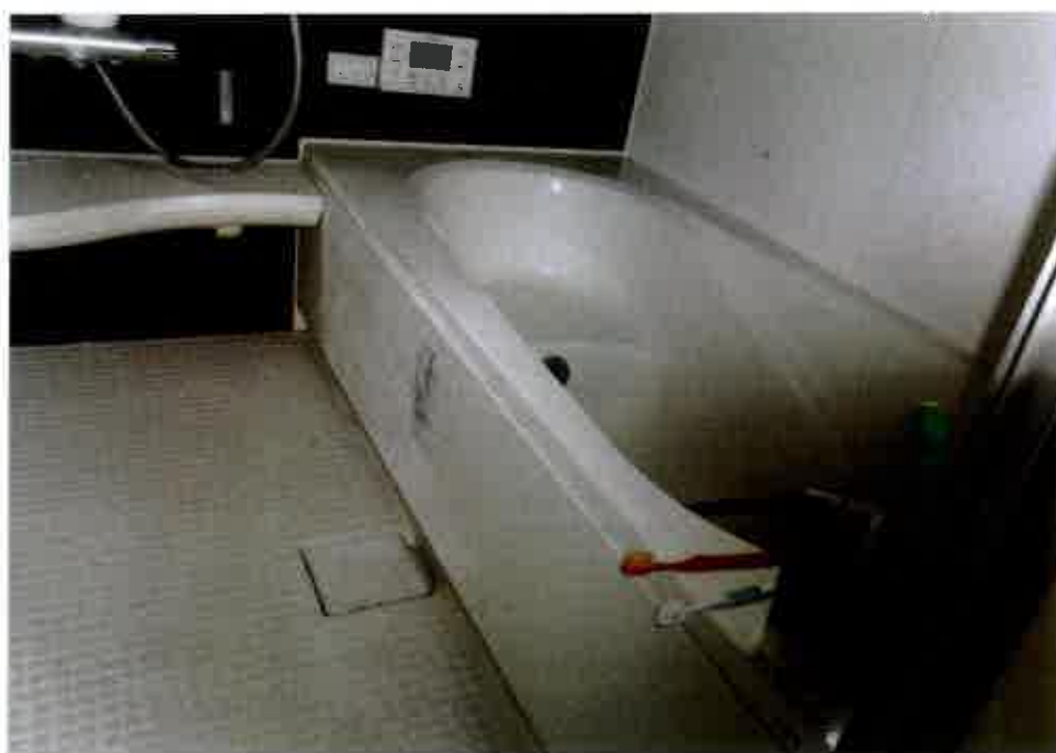
④屋内の状況 浴室
