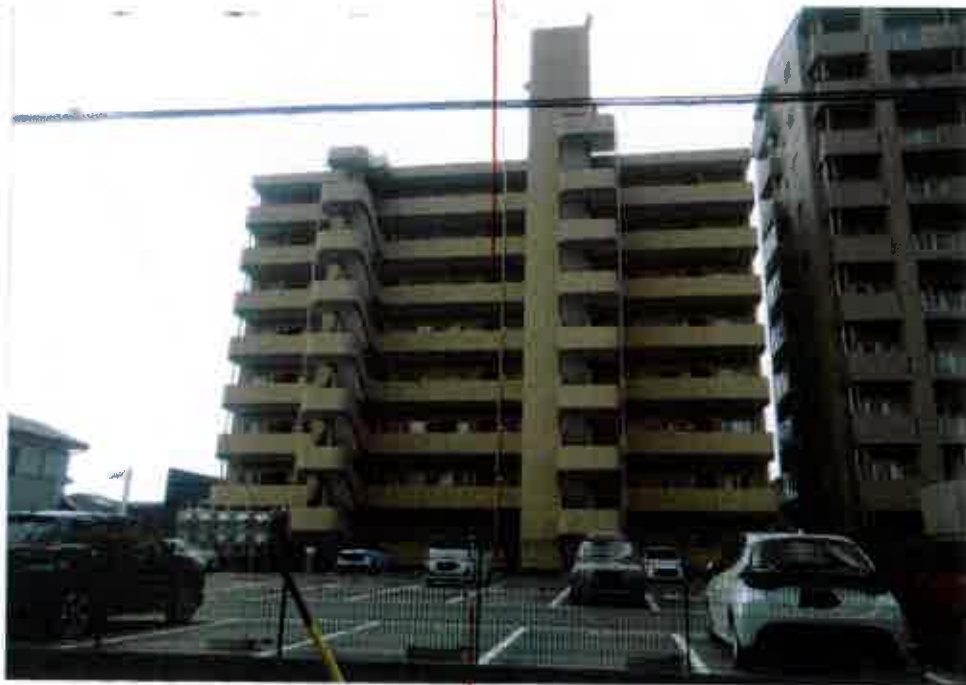
駐車場 屋外の状況
