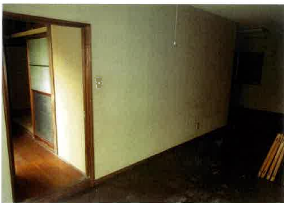
屋内の状況（洋室 1）
