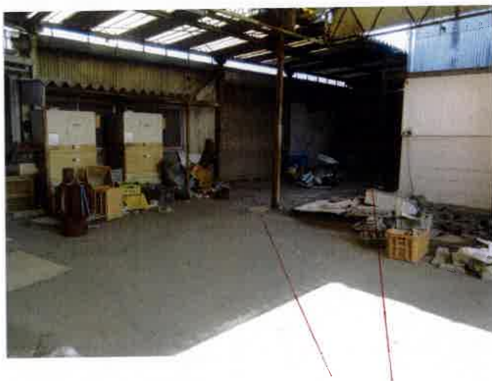
屋外の状況（物件 5 建物未登記増築部分（工場 2・工場 3 出入口）
