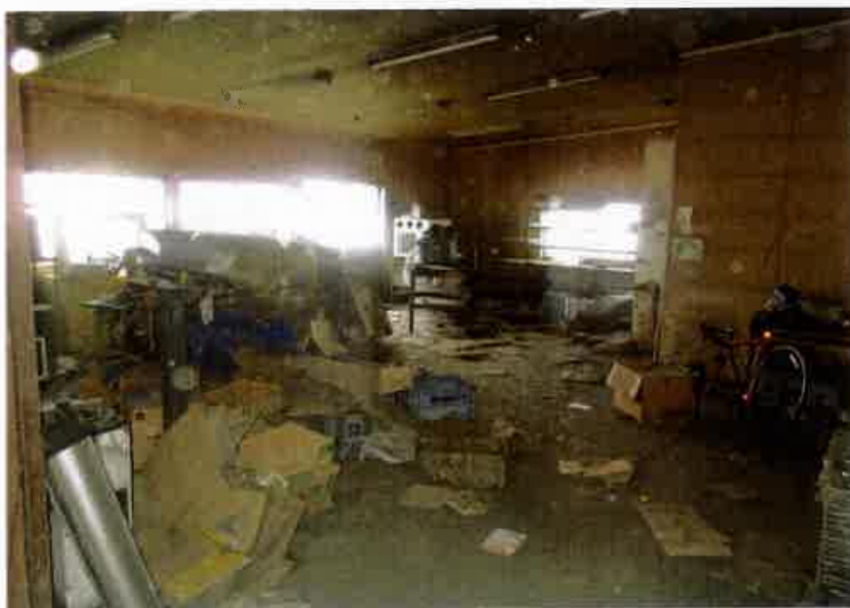
屋内の状況（工場 3）
