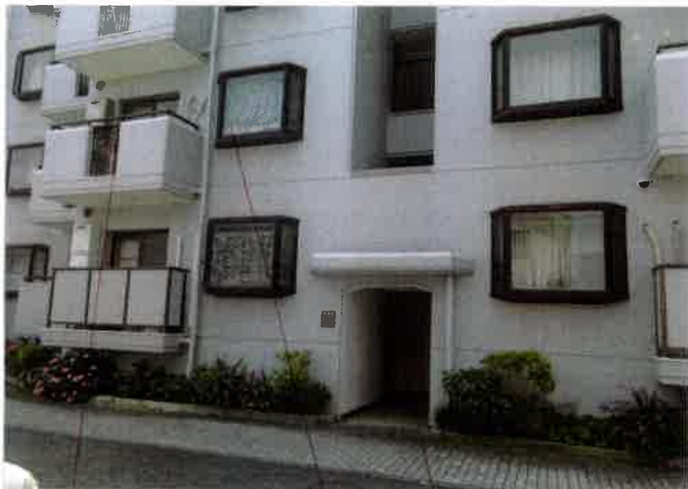
2階北側バルコニー
