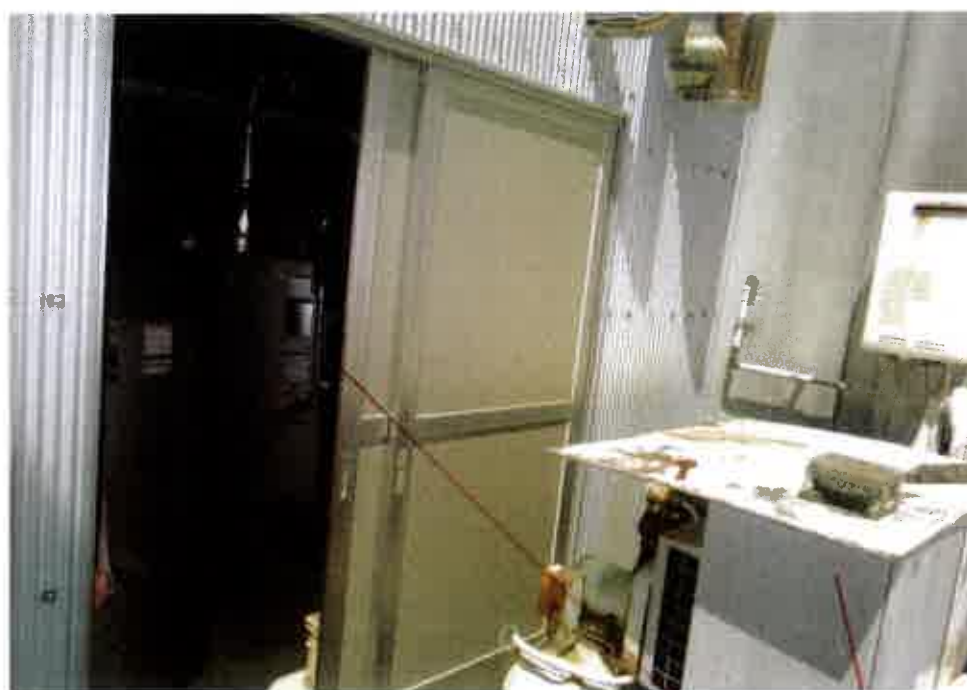
コンプレッサー
