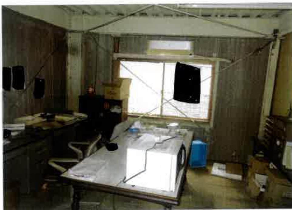
屋内の状況（2階 事務室）
