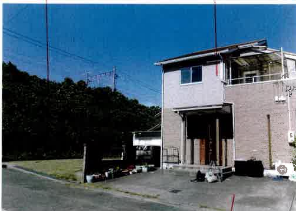
⑧屋外の状況 (南西側から 撮影)
