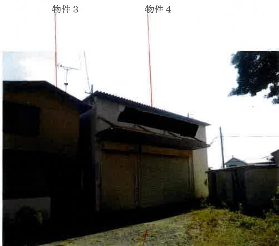
④屋外の状況
