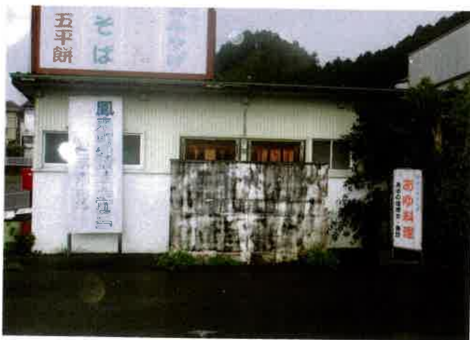
屋外の状況 (附属建物 1 出入口)
