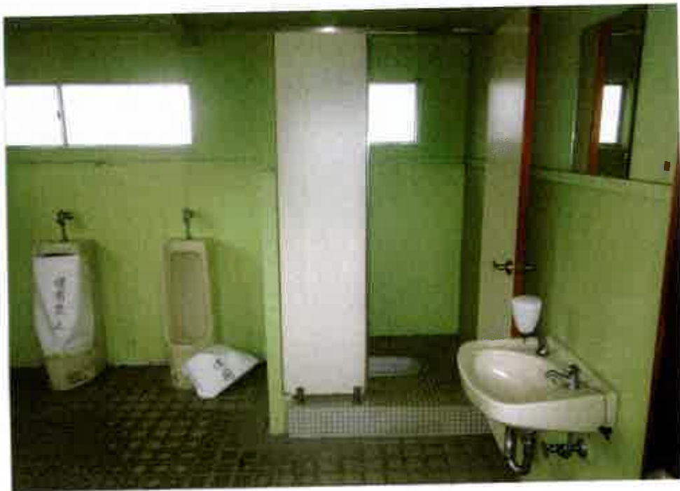
屋内の状況 (男性用便所)
