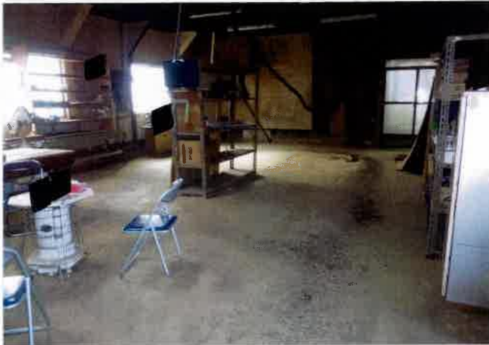
③屋内の状況 作業場 1 (主である 建物)
