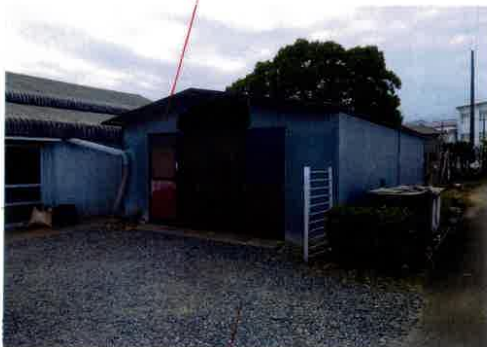
⑧屋外の状況
