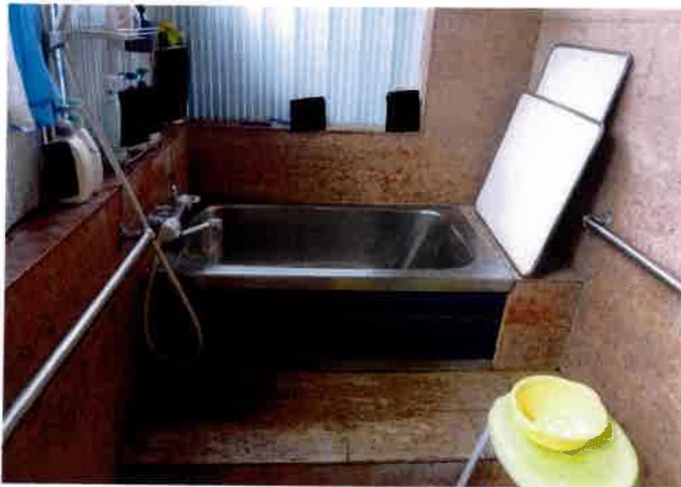
⑤屋内の状況 浴室
