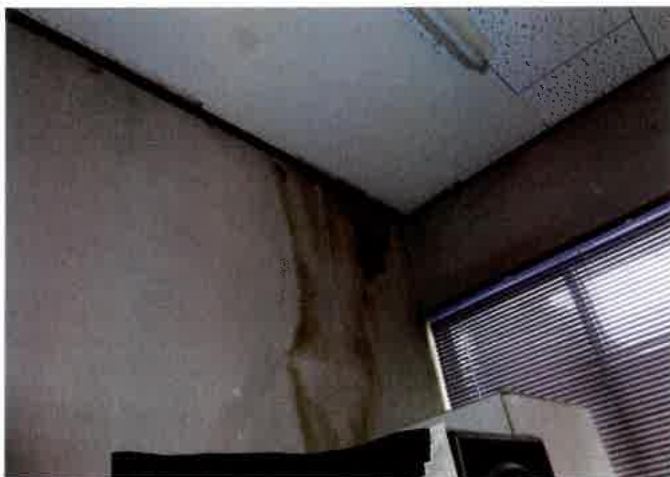
⑧屋内の状況 事務所の 天井の状況
