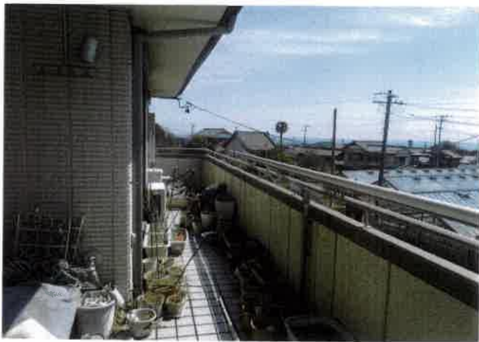
屋外の状況 (2階 バルコニー)
