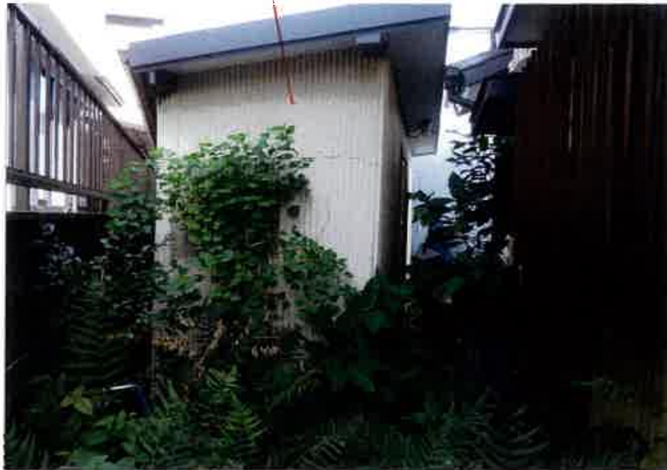
⑦屋外の状況
