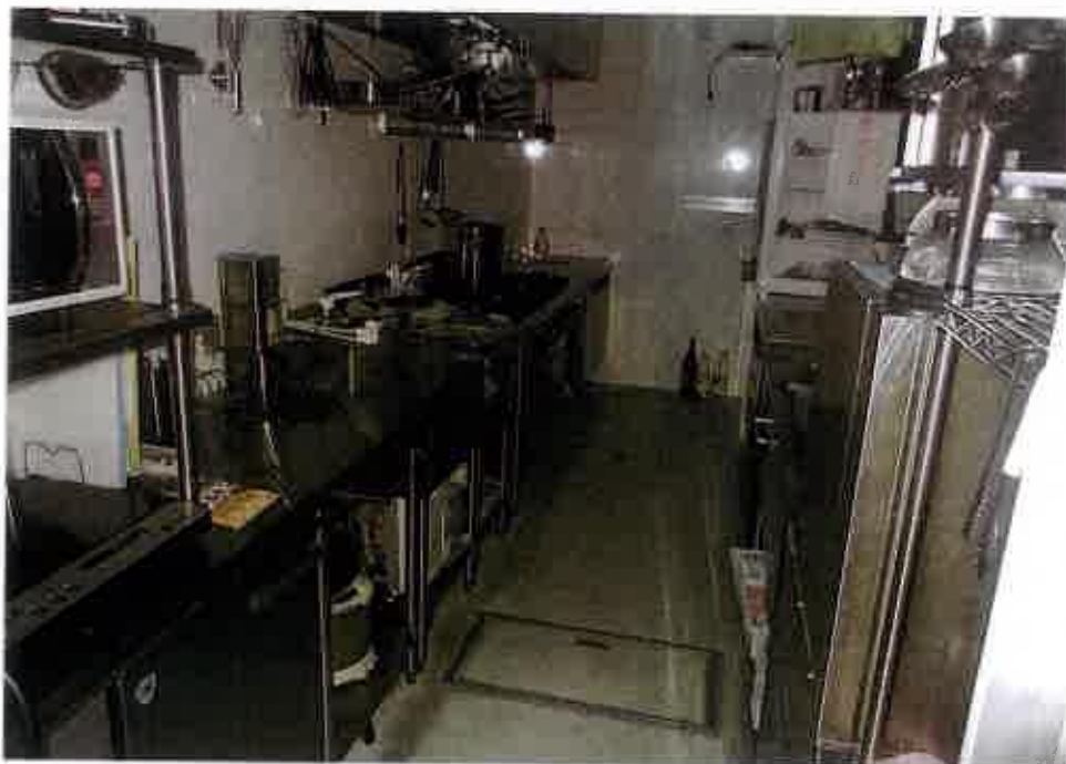
屋内の状況（1階 店舗 厨房）
