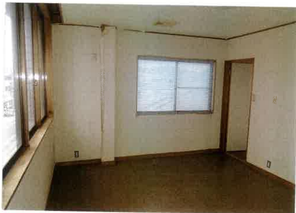
屋内の状況（3階 洋室5）
