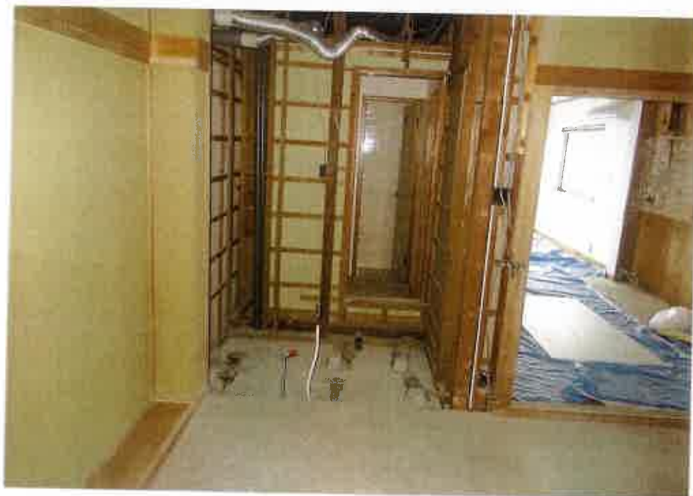
屋内の状況（2階 撤去済の旧浴室・旧脱衣所・旧便所）
