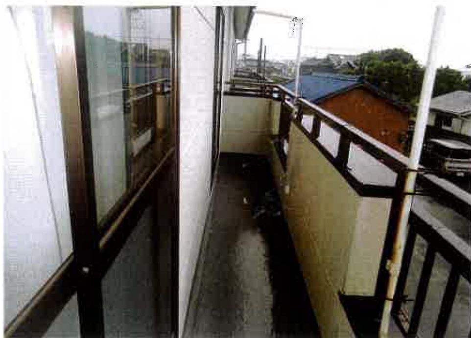
屋内の状況（2階 2A号室 バルコニー）
