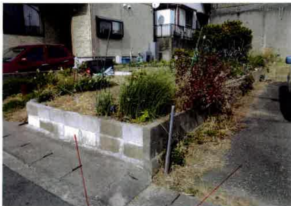
④南側境界 (南角) 付近の状況
