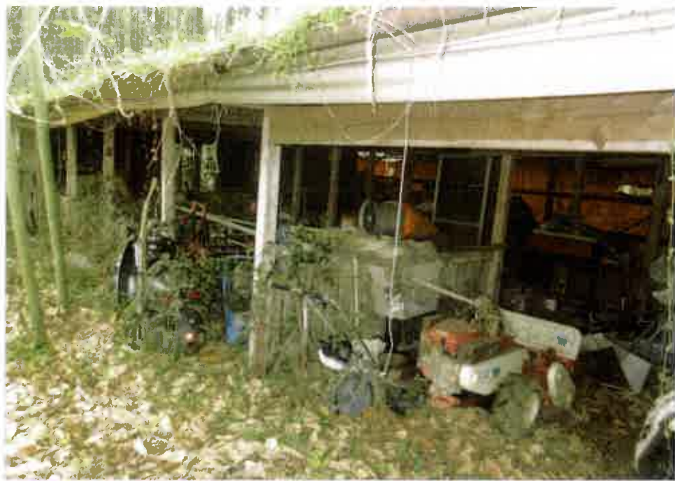
屋外の状況 (未登記附属建物 (畜舎内部))
