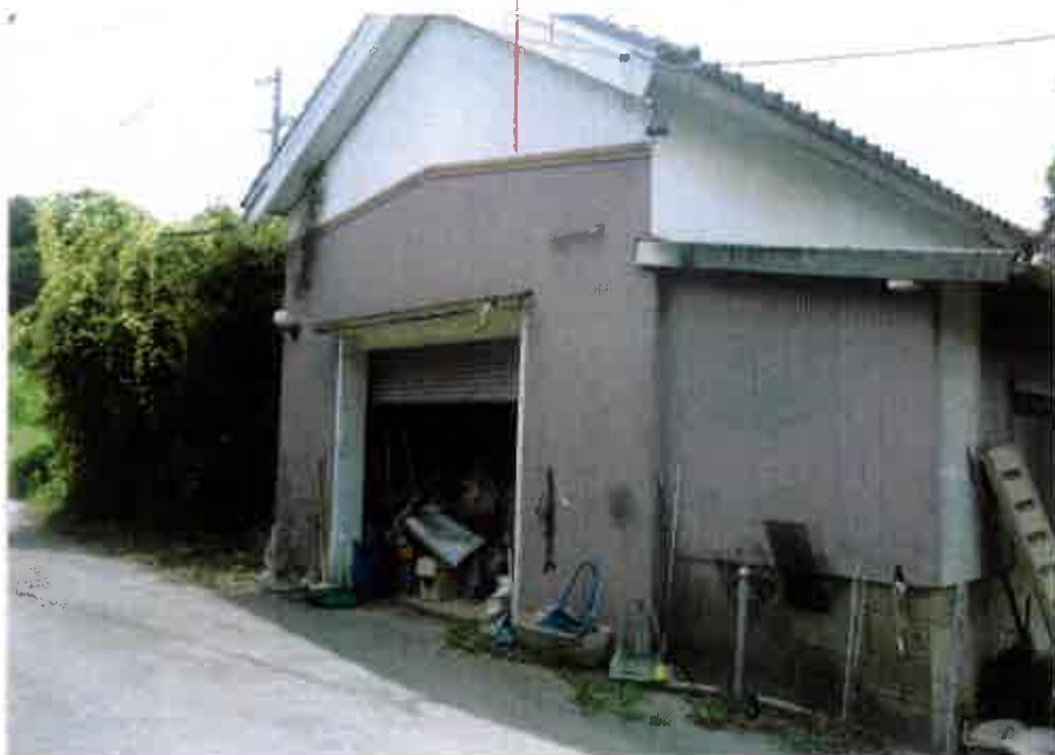
屋外の状況（物置 1 階）
