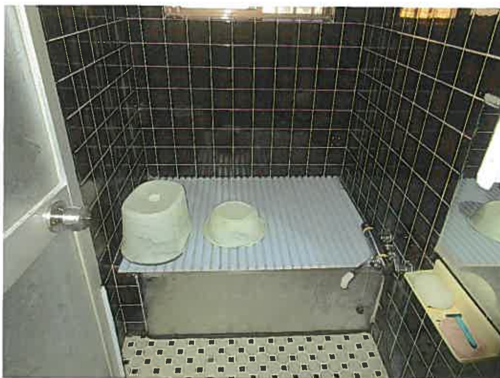
物件 6 建物内部（浴室）
