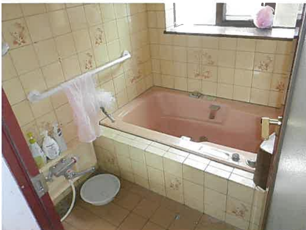
物件 3 建物（浴室）
