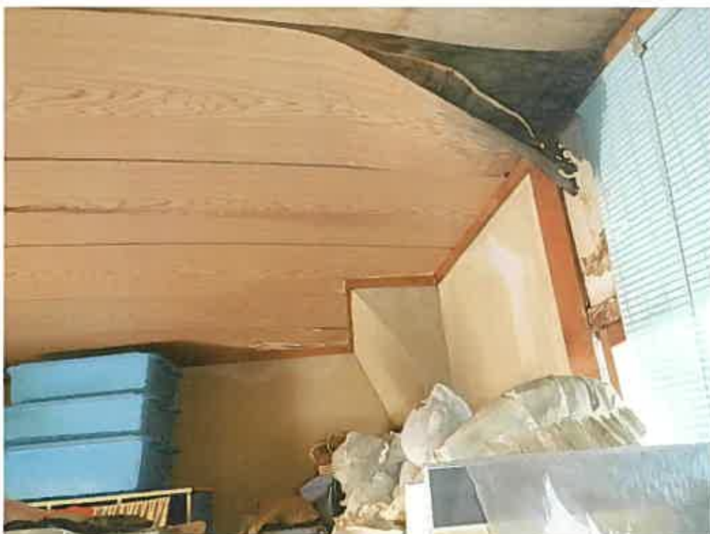
物件 1 5 主建物内部 (2 階居室)
