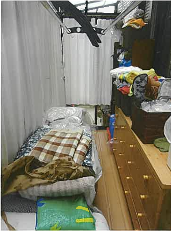
未登記増築部分 (サンルーム) 内部
