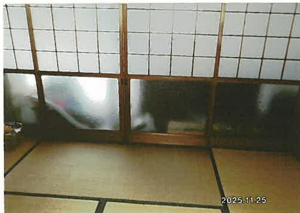
⑦ 物件3(主) 内部
