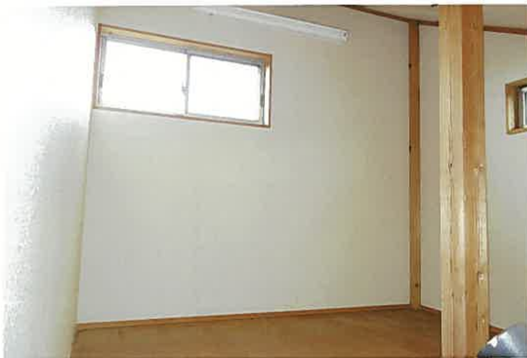
2階吹き抜けスペース部分の床の状況
