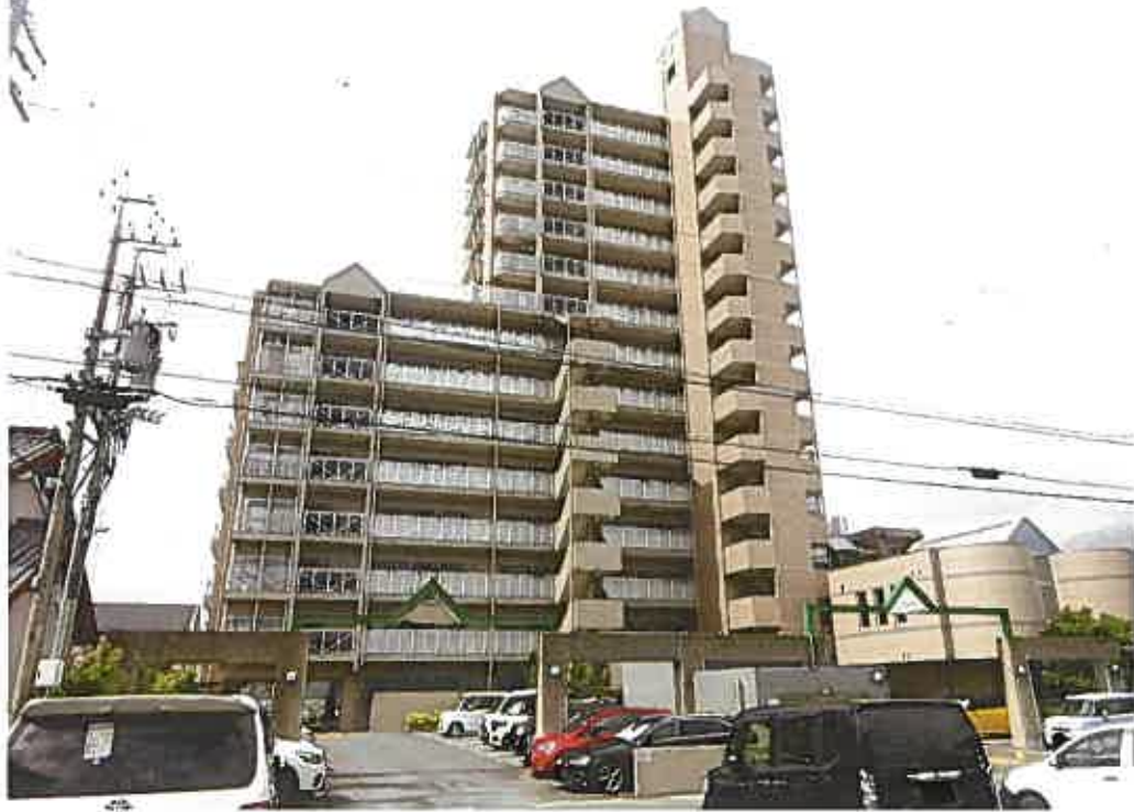
本件マンション 全景
