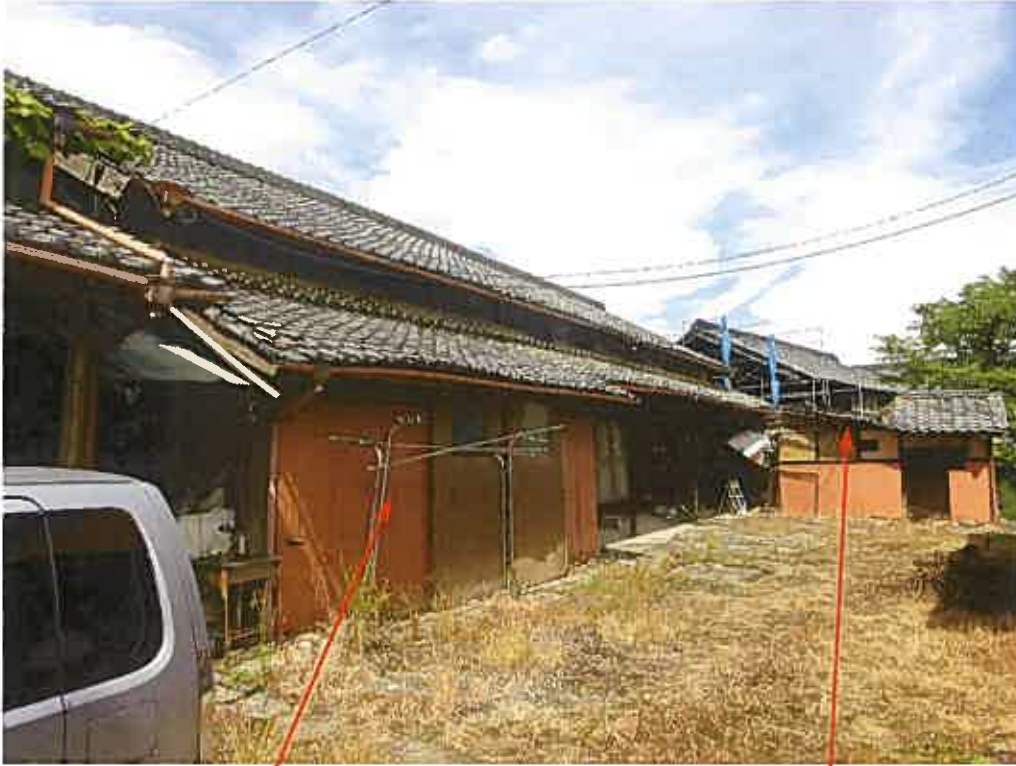
物件 5 主たる建物
