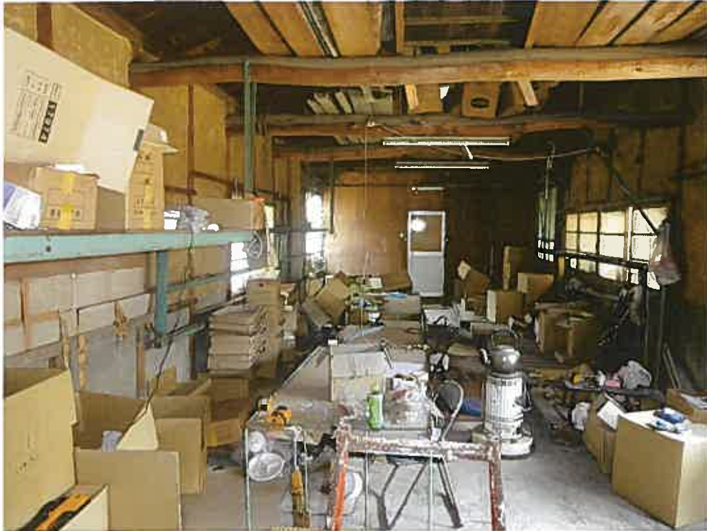
物件 4 建物 内部を撮影
