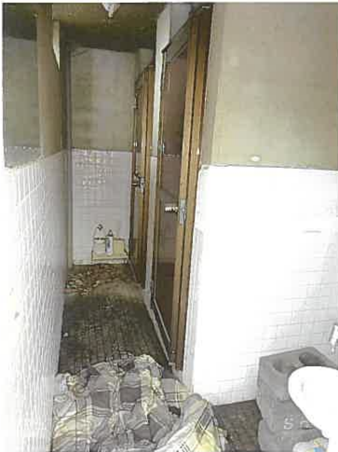
物件 6 建物の未登記附属 建物（便所）
