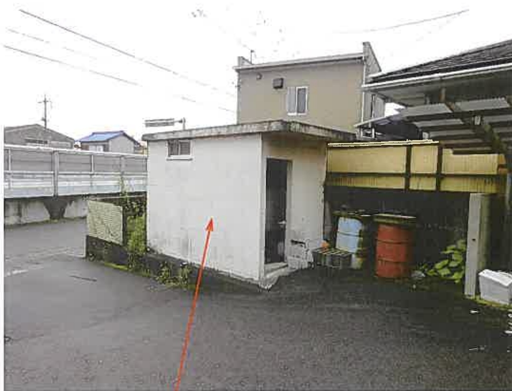
物件 6 建物の未登記附属建物（便所）
