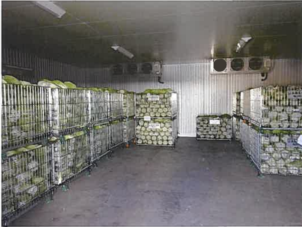
物件4建物 附設冷蔵庫 内部を撮影
