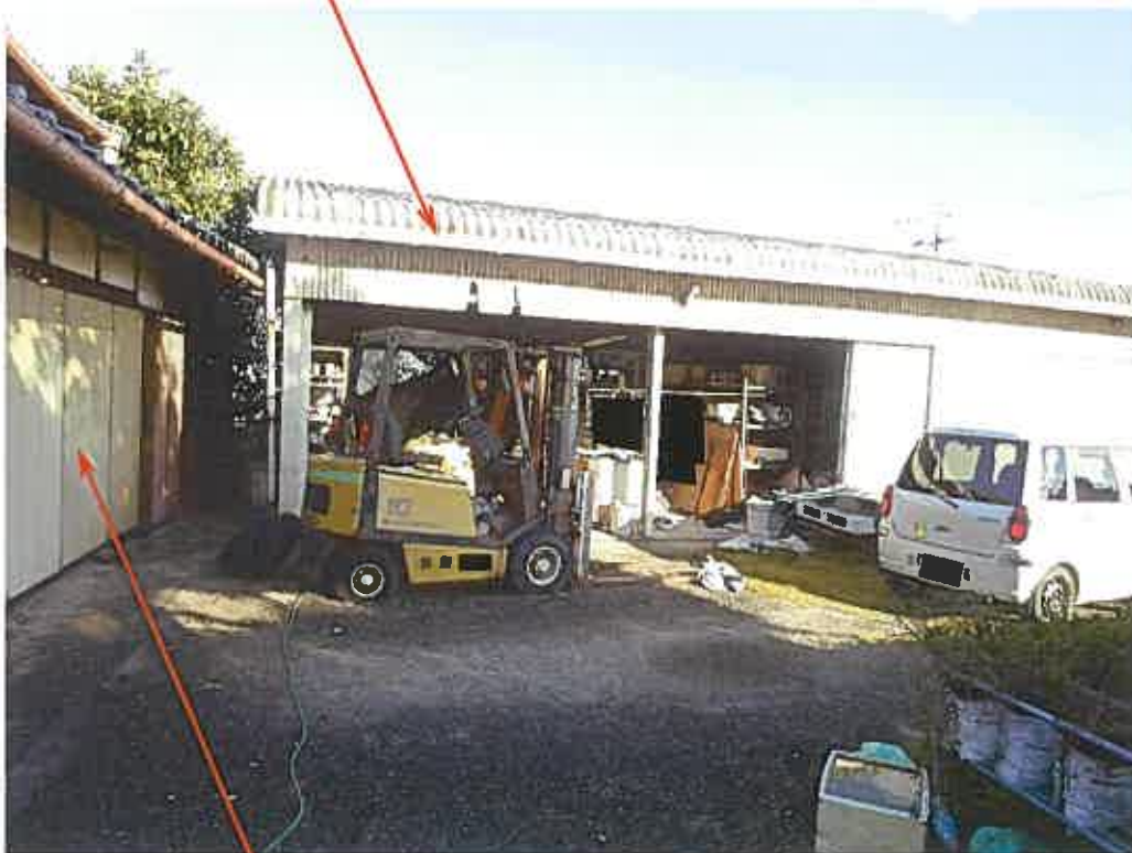
物件 6 主である建物
