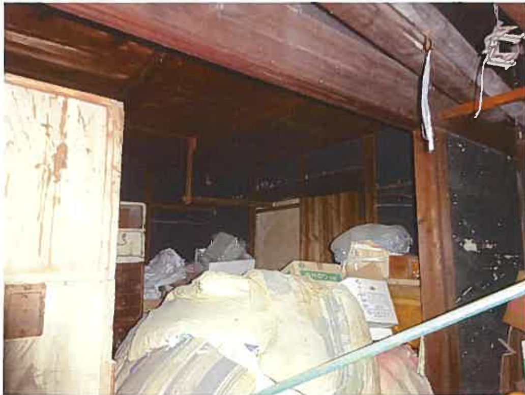
物件 6 附属建物 符号 1 内部
