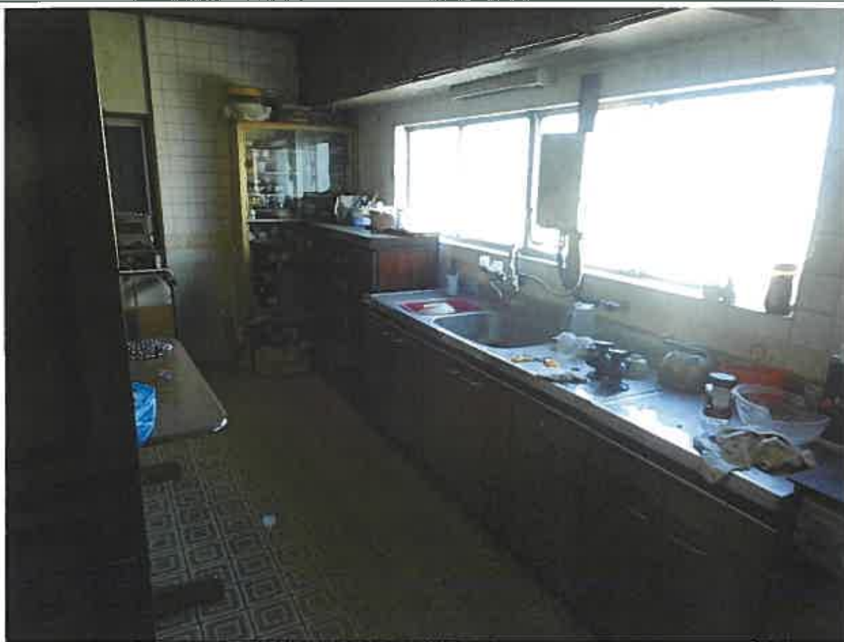
物件2建物・附属内部
