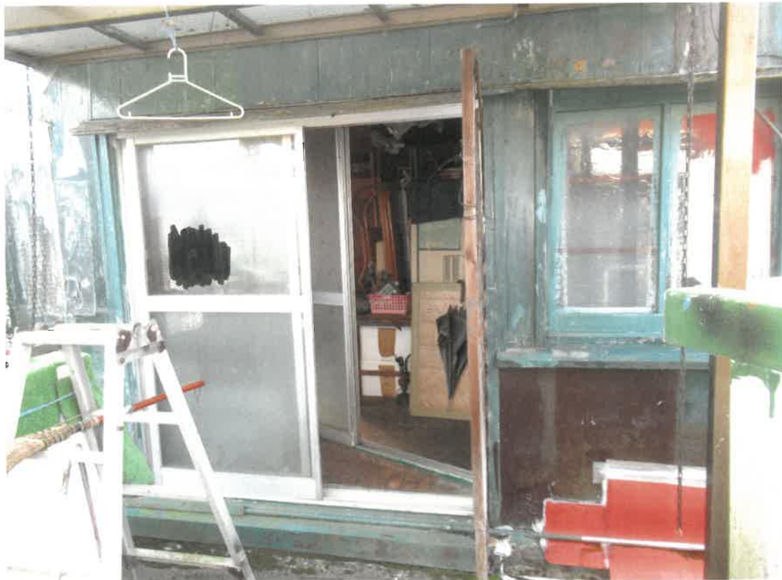
物件2建物の内部
