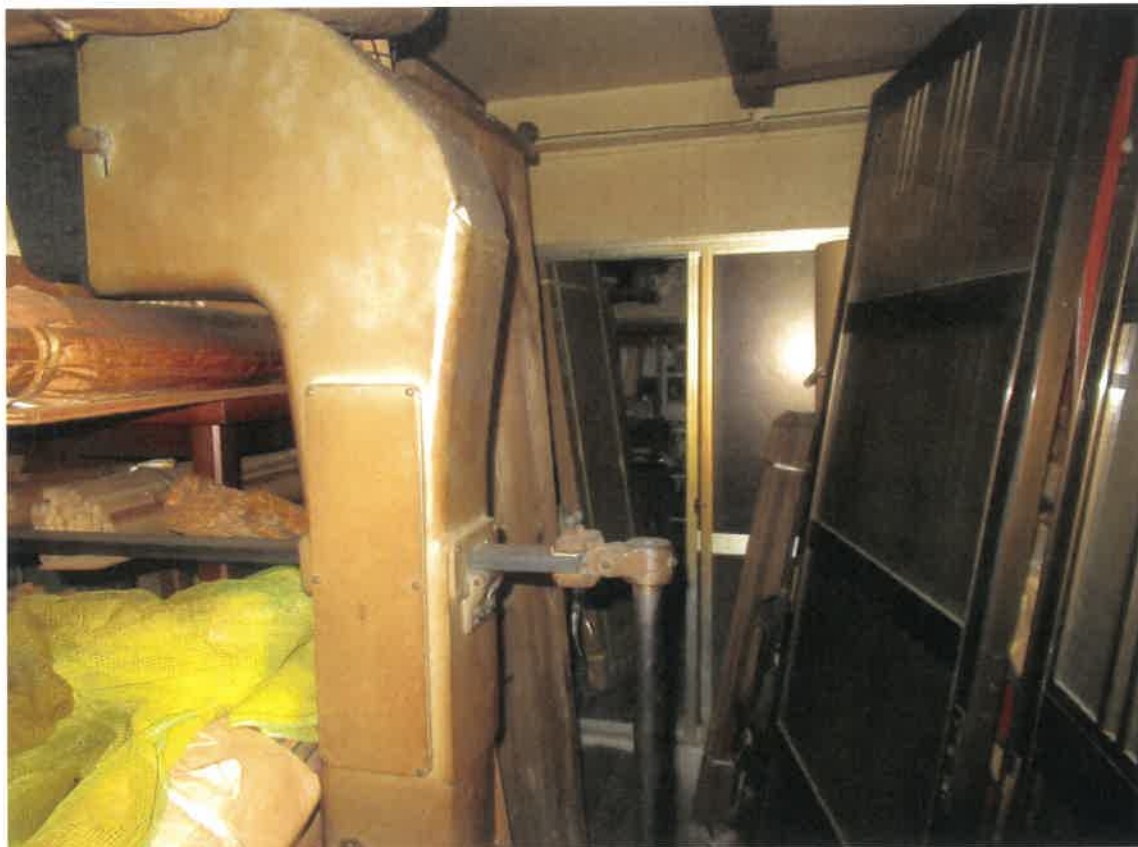
物件2建物の内部
