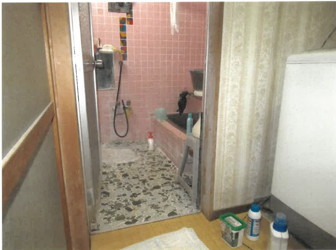
物件3建物の内部
