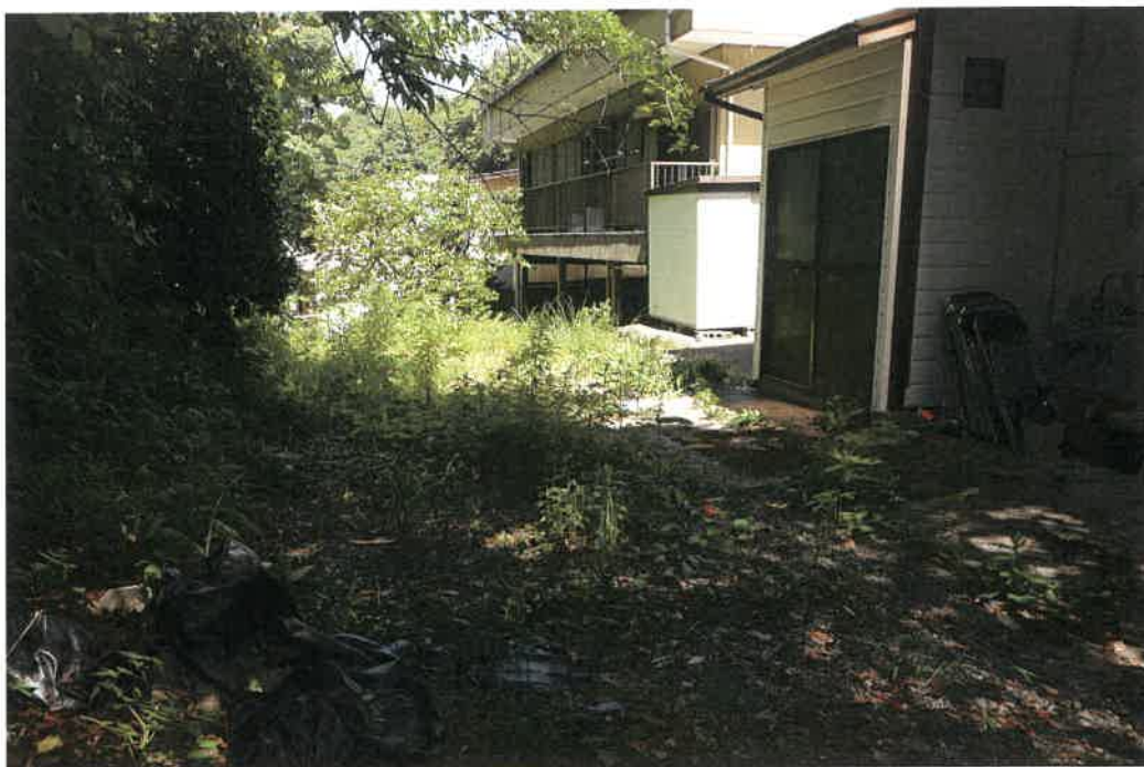
目的外建物（602-2）のピロティ部分
