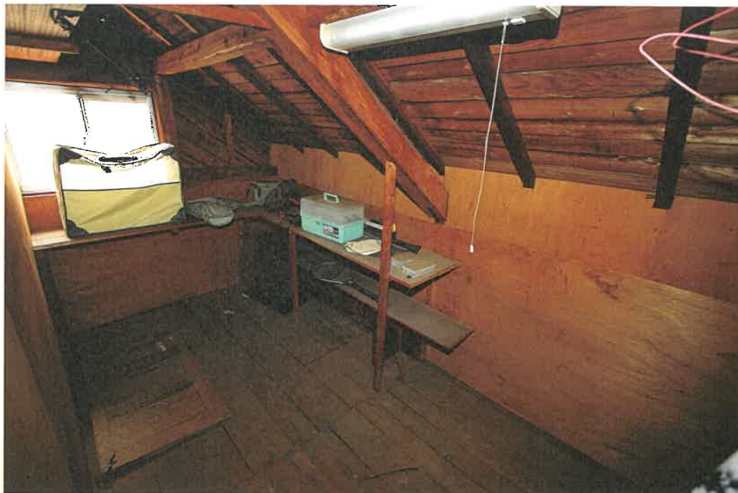
物件 2 主建物 2 階 物置部分
