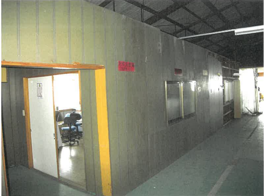
前同建物の2階倉庫前
