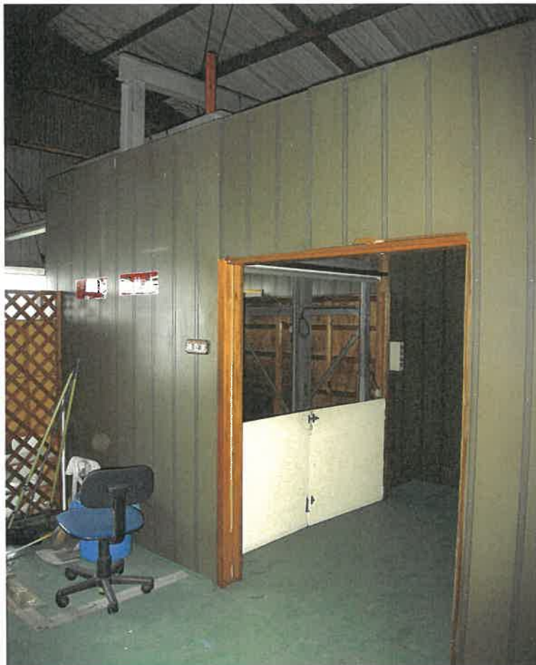
前同建物の2階リフト前
