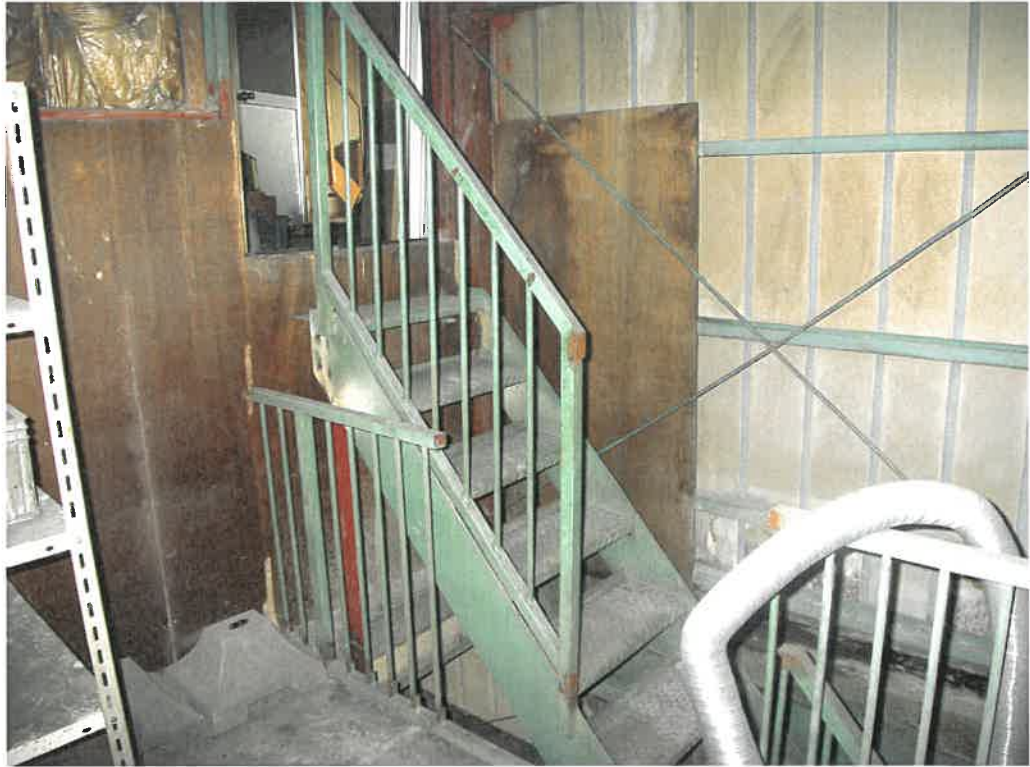
前同建物の2階踊り場内
