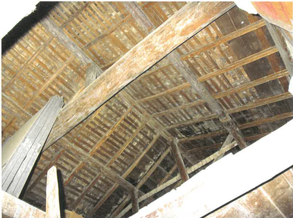
前同建物の2階室内
