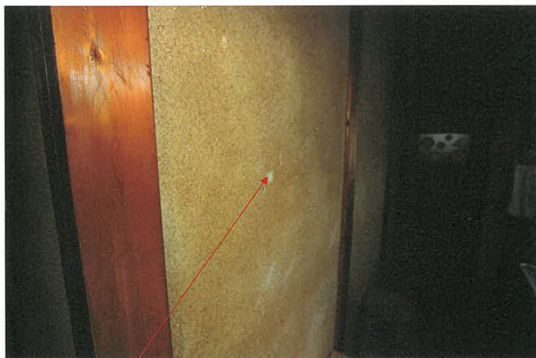
穴 物件 5 附属建物 1 室内
