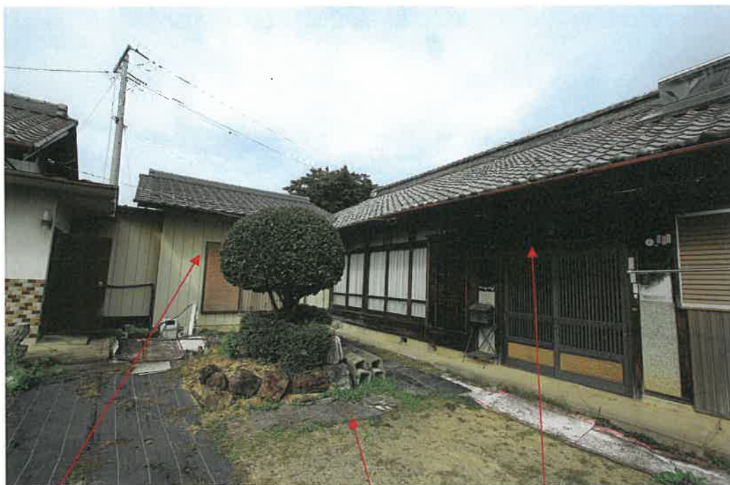
物件 5 附属建物 1
