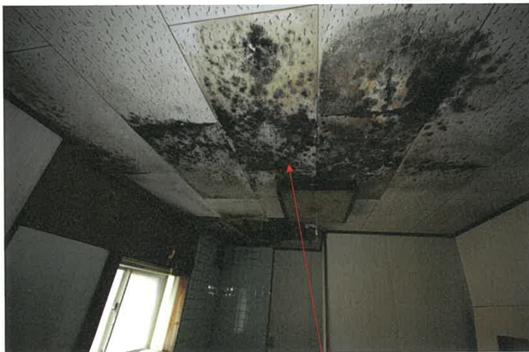
物件 5 主建物 室内
