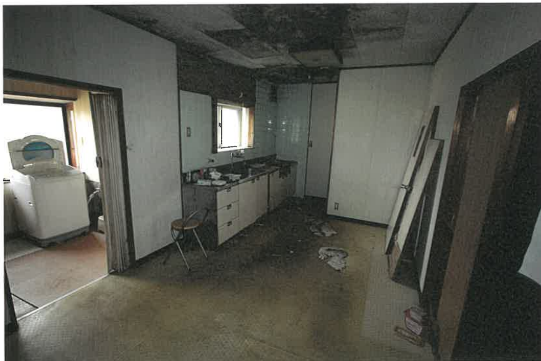
物件 5 主建物 室内
