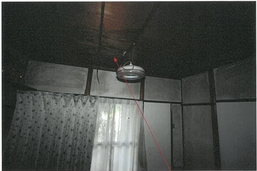
物件 5 主建物 室内
