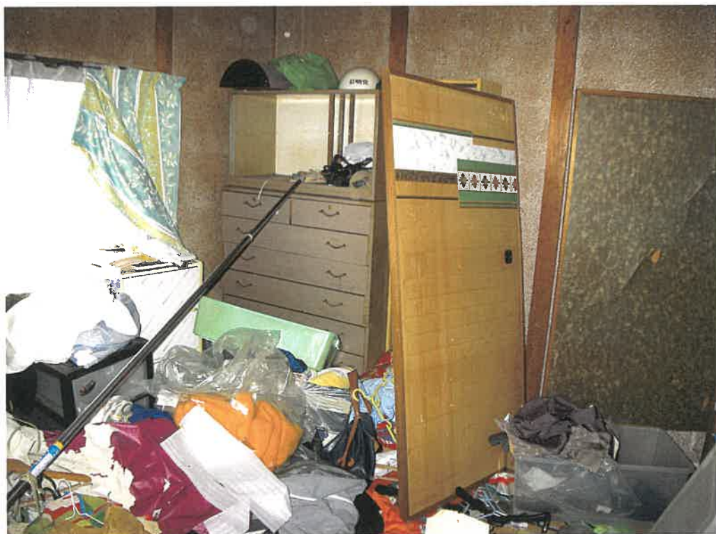
前同建物の2階室内
