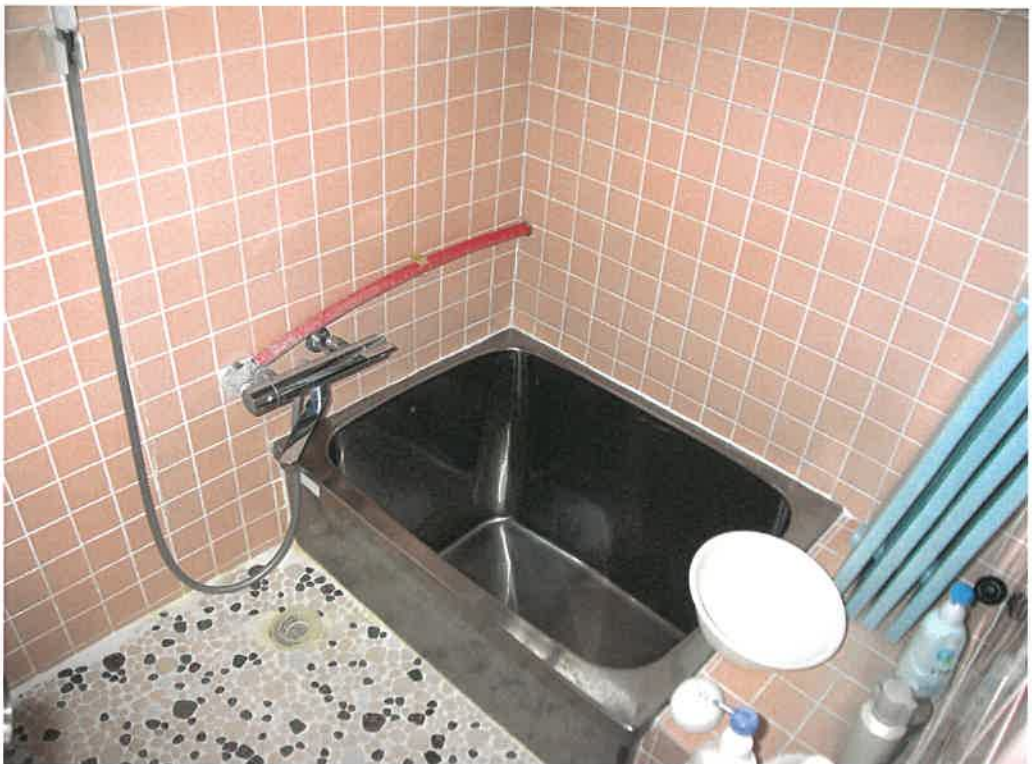
前同建物の1階室内
