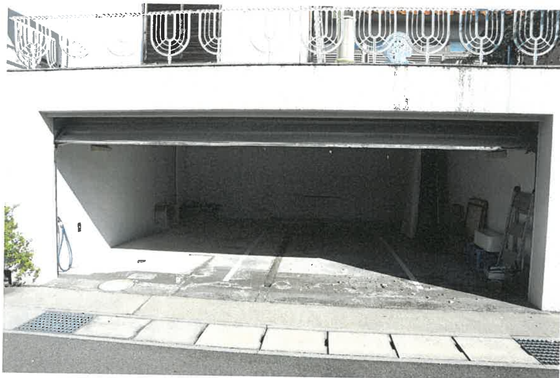
物件 2 附属建物内（車庫）
