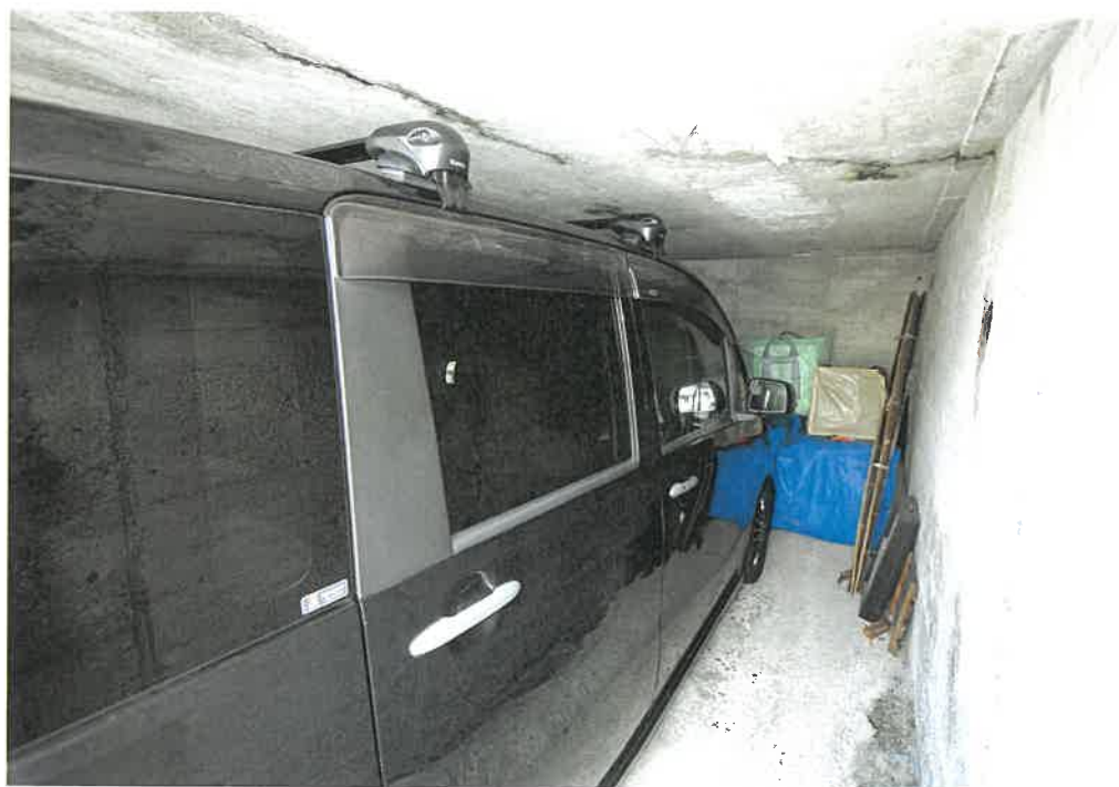
物件 2 附属建物 1 室内
