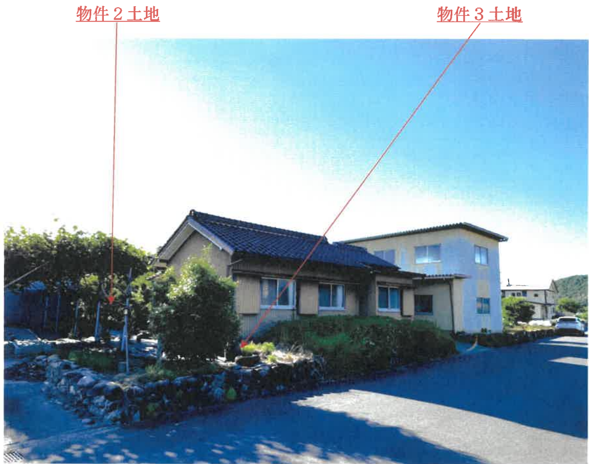
目的物件の現況写真
