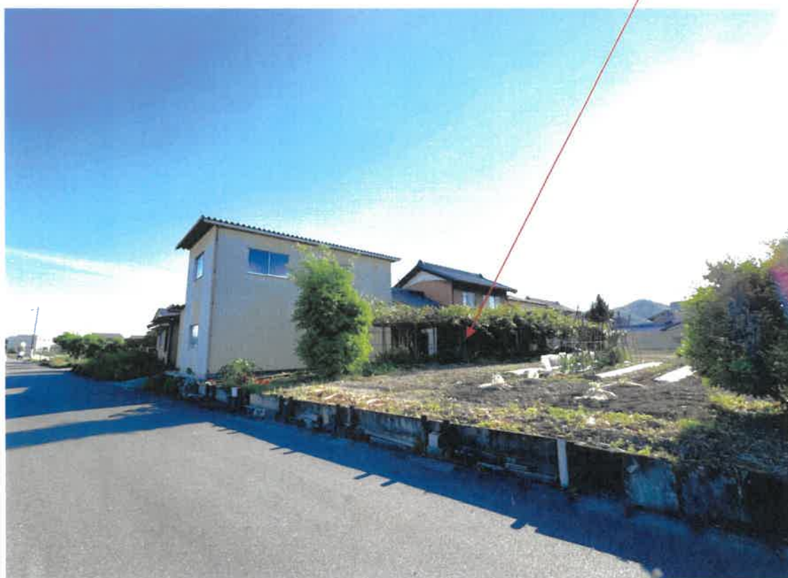
目的物件の現況写真
