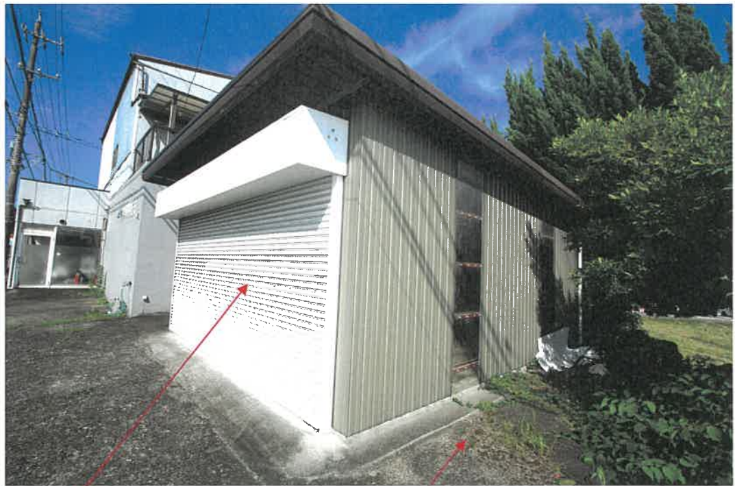
物件 5 附属建物 1
