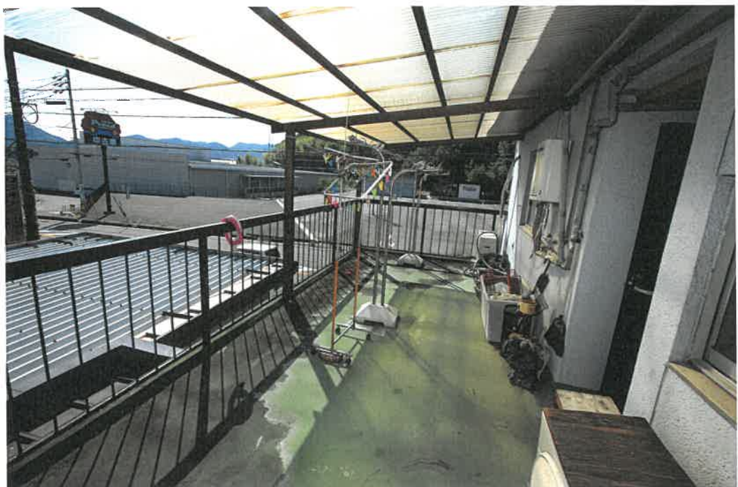
物件 5 主建物 3 階ベランダ
