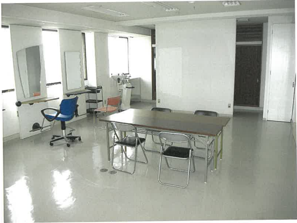
前同建物の4階会議・研修室内
