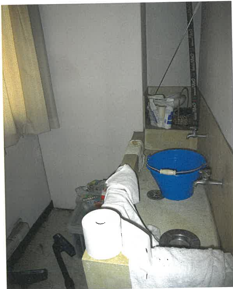
前同建物の2階事務室内
