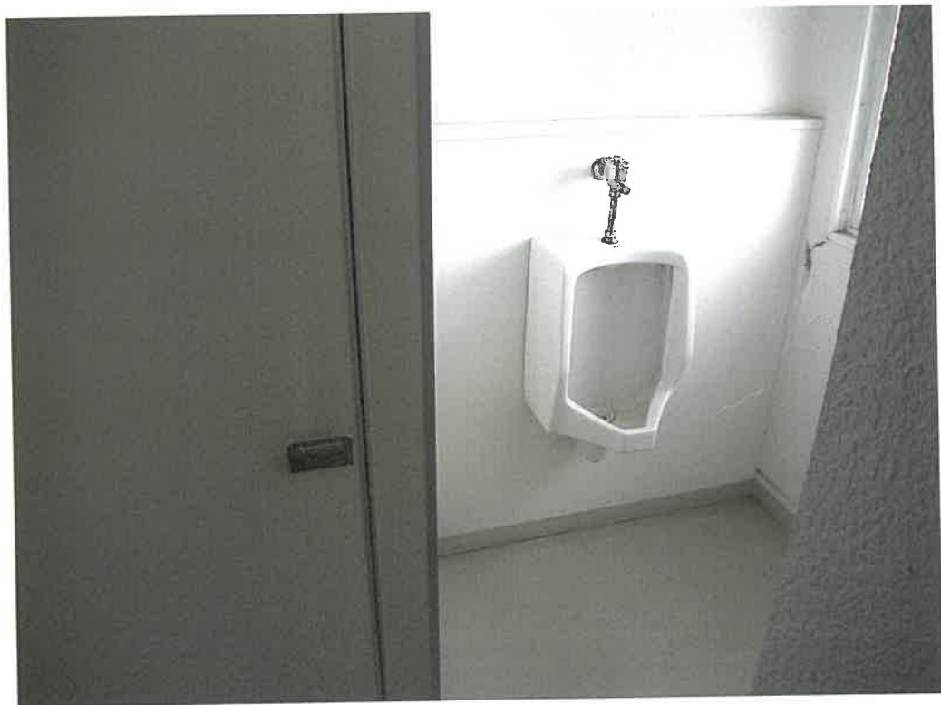
前同建物の4階トイレ内（未登記増築部分）
