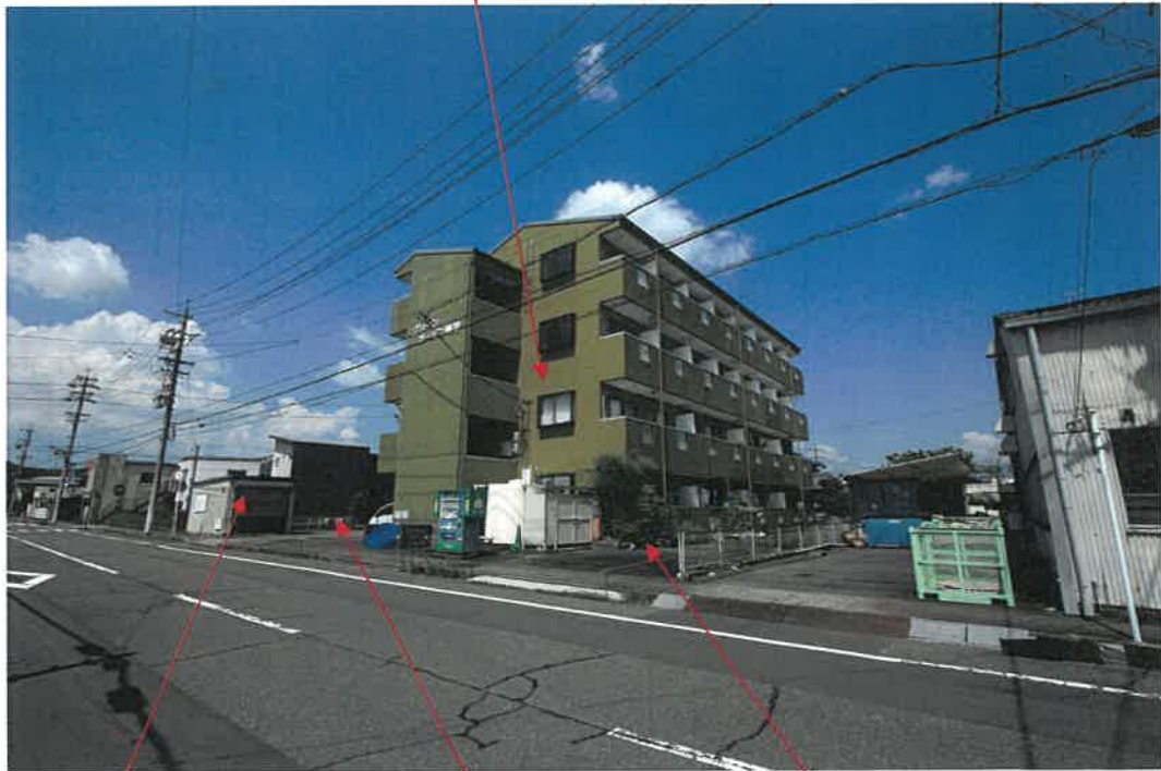
物件 4 附属建物 1
