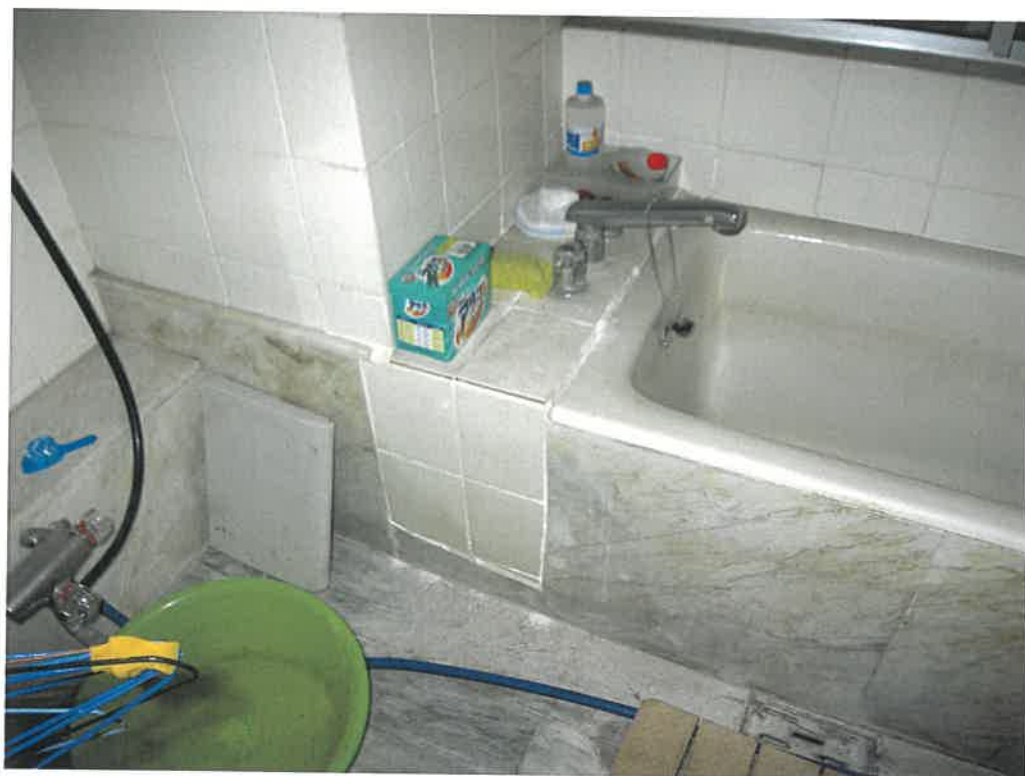
前同建物の3階室内
