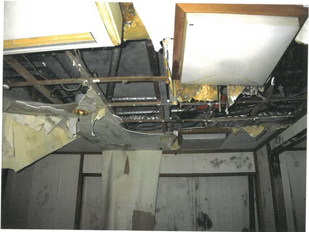
前同建物の地下1階店舗内（天井部分）
