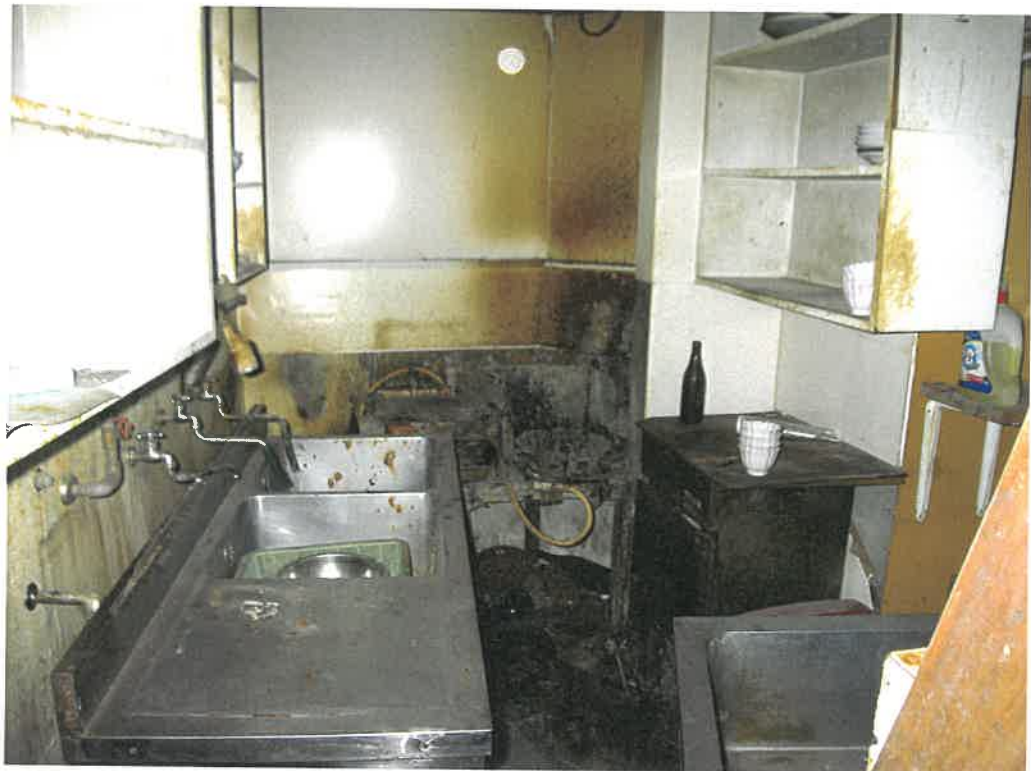
前同建物の地下1階店舗内
