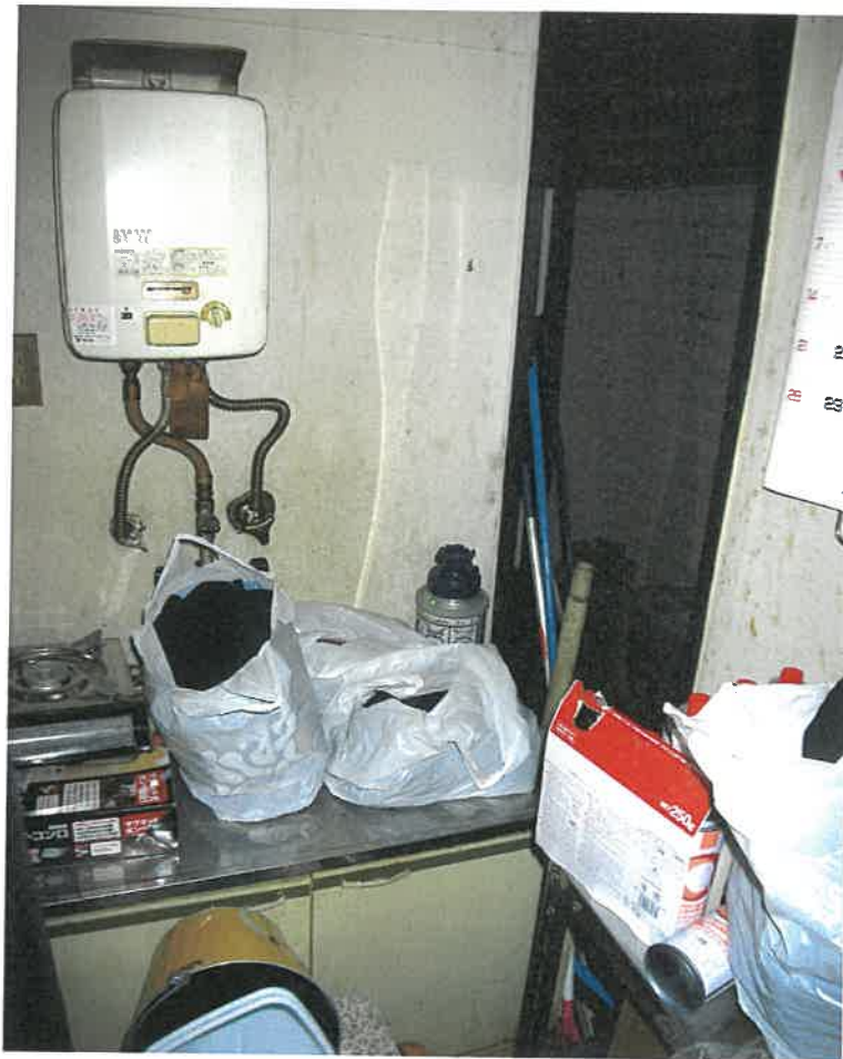
前同建物の2階店舗内
